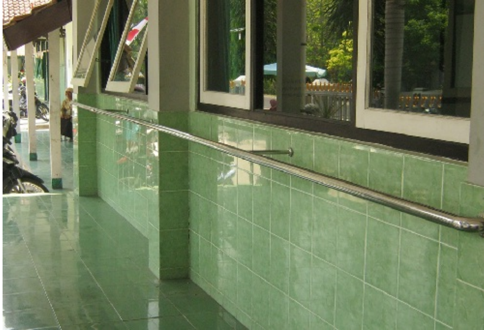
Gambar 2.4 Dinding dilengkapi dengan Pegangan
