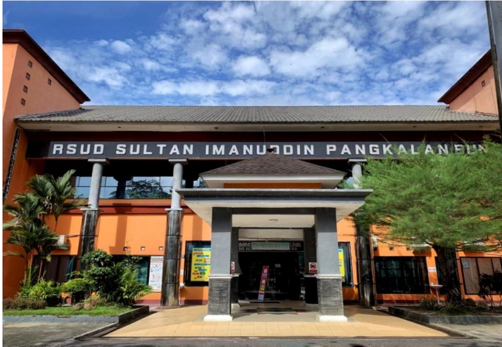
Gambar 5.1 Gedung RSUD Sultan Imanuddin Pangkalan Bun
